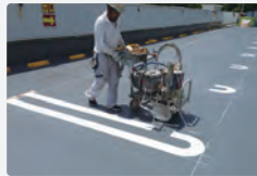
指示誘導ライン工事
