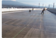
プライマー施工
