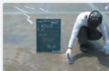
クラックシーリング補強
