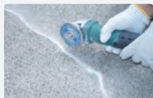
クラックUカット施工
