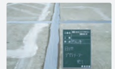
目地処理完了
