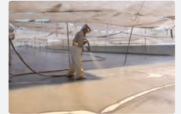
超速硬化ウレタン吹き付け
