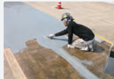
ウレタン層1層目施工
