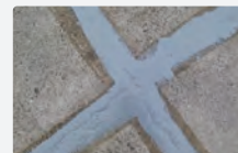
設置後シーリング処理
