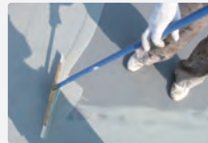
硬質ウレタン層+防滑珪砂施工
